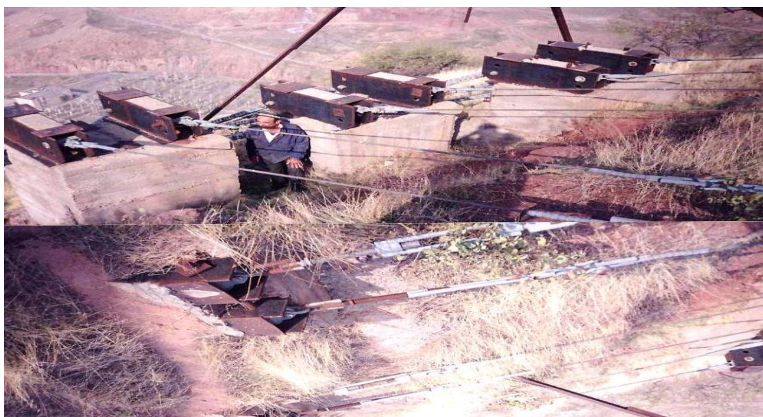
Рис.1. Вид анкерного закрепления перекидки ЛЭП -500 кВ на ОРУ-500 кВ Нурекской ГЭС. Скальное закрепление каждой фазы III-ей цепи ЛЭП замоноличено на высоту (170-175 см.). Фаз – три, поэтому установлено три тумбы замоноличенных анкеров. Массив сложен прочными песчаниками, (Фото Арифова Х.)
