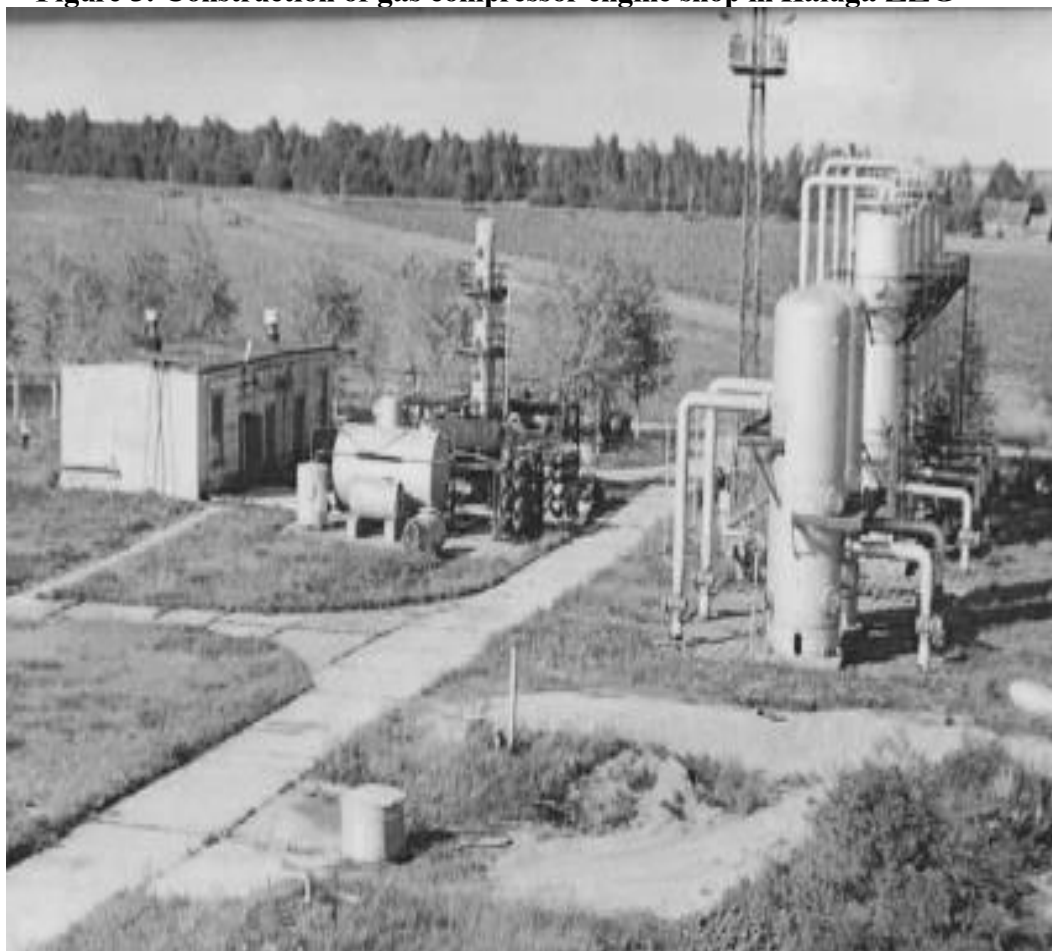
Расми 3. Сохтмони сеҳи муҳаррикҳои компрессории газӣ дар ЗЗГ-и Калуга Figure 3. Construction of gas compressor engine shop in Kaluga ZZG
