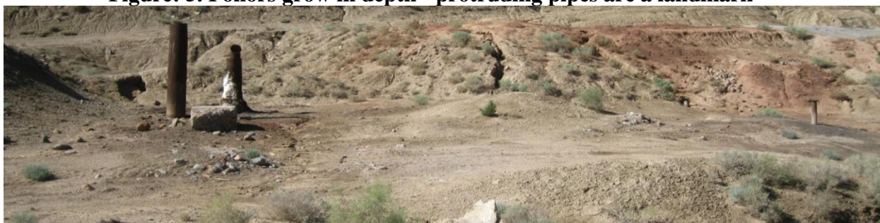
Рис. 5. Поноры растут в глубину - ориентир торчащие трубы Figure: 5. Ponders grow in depth - protruding pipes are a landmark
