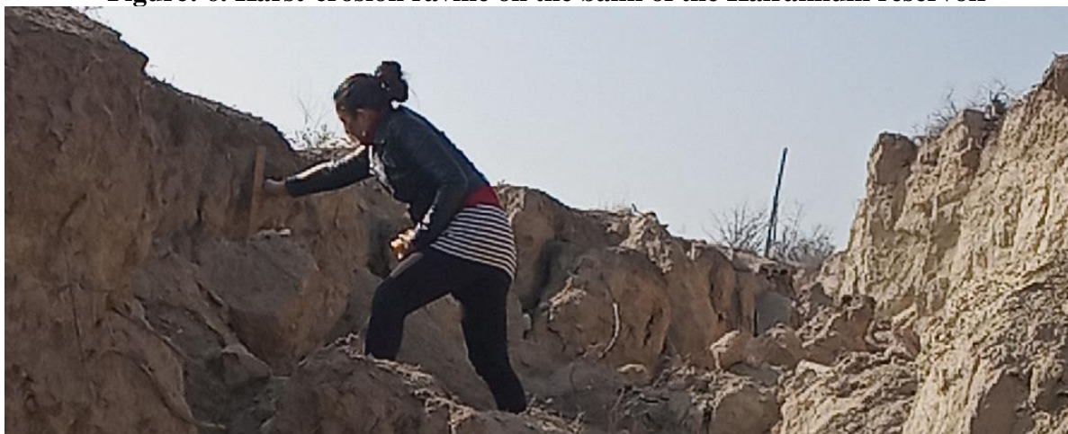
Рис. 6. Карстово-эрозионный овраг на берегу Кайраккумского водохранилища Figure: 6. Karst-erosion ravine on the bank of the Kairakkum reservoir
