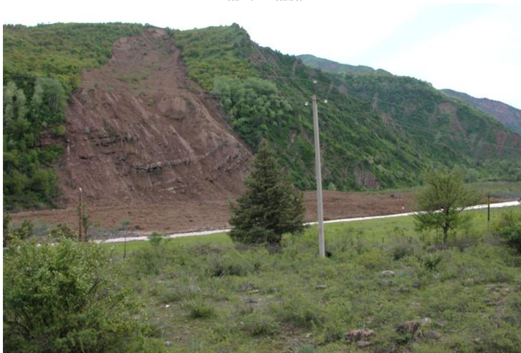
Рис 5. Оползень на склоне левого борта р. Обихингоу, восточнее кишлака Дашти Хасан Figure 5. Landslide on the slope of the left side of the Obikhingou river, east of the village of Dashti Hassan
