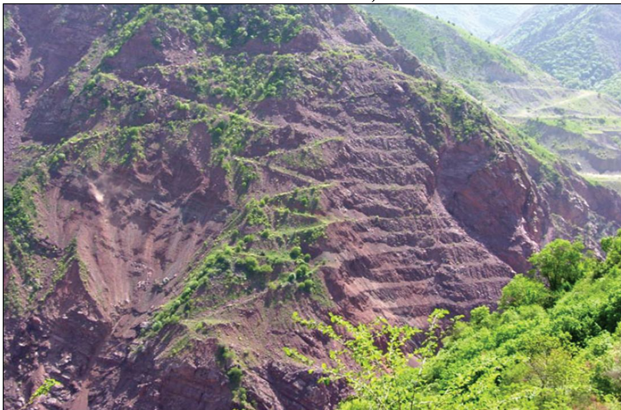
Расми 3. Тағйирдиҳии сунӣи релйефи нишебии соҳили чапи дарёи Вахш (дар Бйефи поёнӣ) барои таъмини устувории сарбанд Figure 3. Artificial change in the relief of the slope of the left bank of the Vakhsh River (the lower reaches of the dam)
